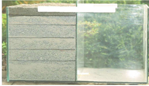
Abb. 29 zeigt den schichtweisen Einbau des Basaltgruses.
