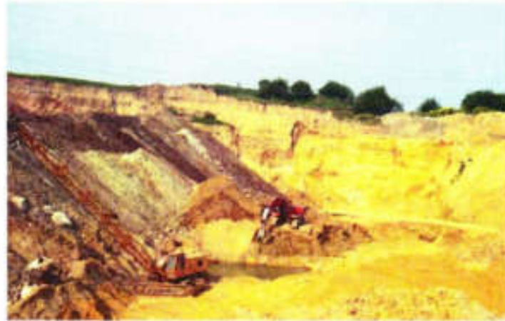
Abb. 45 zeigt einen Teilbereich der Sandgrube in Löhfelden.
