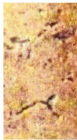
Abb. 21 zeigt Hohlräume im verdichteten Sand.
